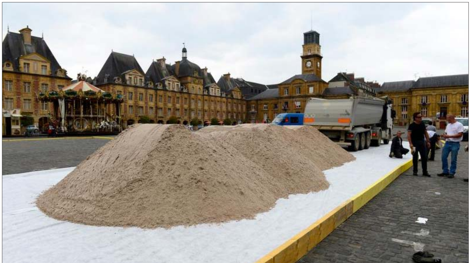
Hier deux camions ont déversé une partie des 300 tonnes de sable nécessaires. Deux déchargements auront encore lieu aujourd'hui et demain. Karen Kubena
