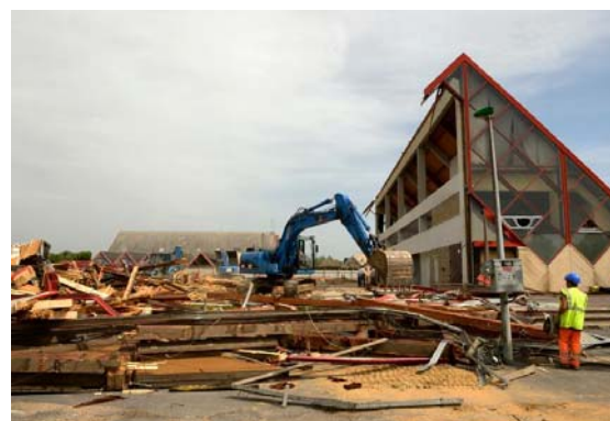
Dans cette partie sera notamment créé l'espace VIP. K. Kubena
